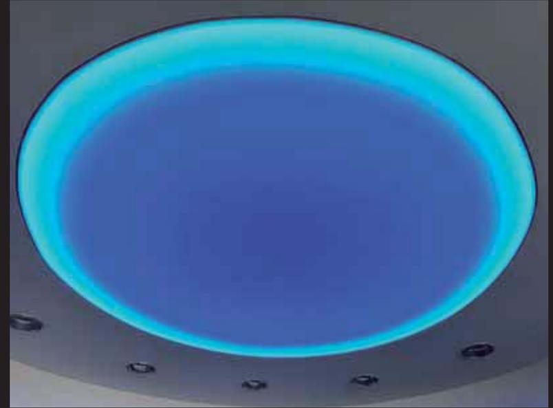
I soffitti tesi sono membrane realizzate con un polimero a memoria di forma. Il sistema di montaggio è molto semplice e prevede un profilo perimetrale e un telo tenuto in tensione sul profilo a mezzo di un'arpione semirigido saldato sul telo stesso.
