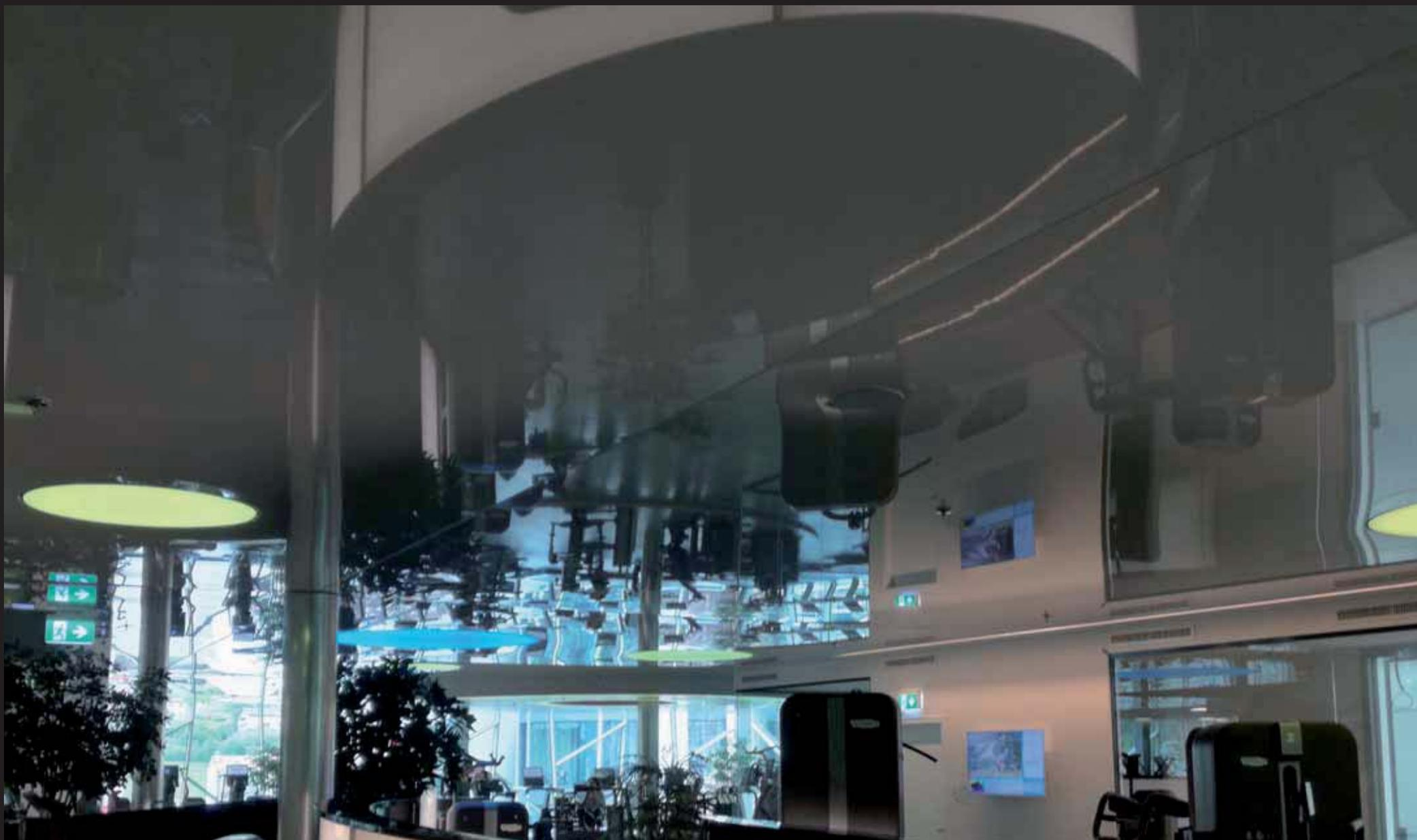
Le membrane termotese in PVC si inseriscono nel settore delle controsoffittature e dei rivestimenti in generale. Rispetto ai classici controsoffitti in cartongesso, un soffitto teso è più pratico, si installa in giornata senza sporcare e non necessita di opere murarie, si può sostituire in modo intercambiabile, assorbe i suoni, offre decine di soluzioni dall'incredibile impatto visivo e molto altro.
